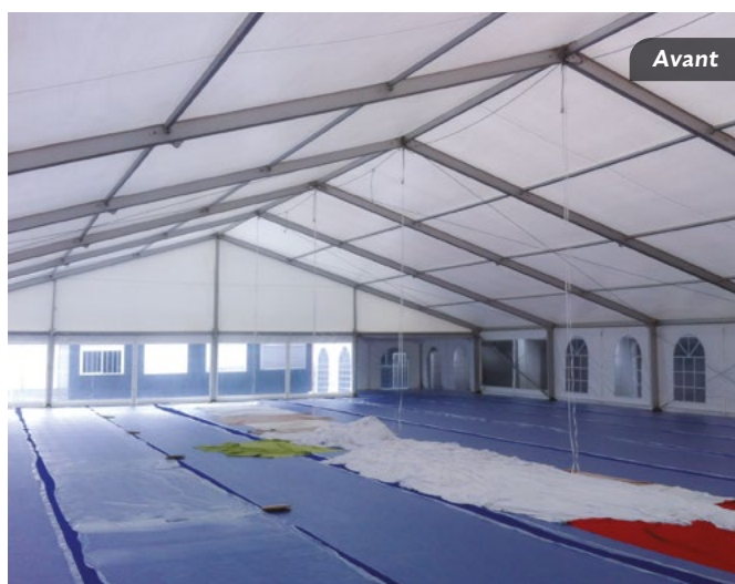
Confection et pose d'un vélum de 30 mètres de long en Jersey elasthanne - Chapiteau VIP, FC Metz
